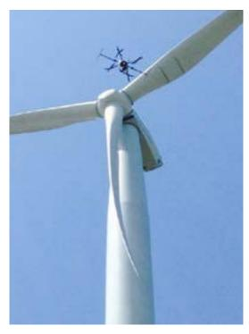
WIND TURBINE INSPECTION USING DRONE
